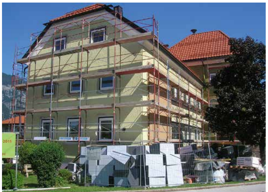
Die Sanierungsarbeiten beim ehemaligen Gemeindeamt sind bald abgeschlossen
